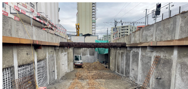
Vorbereitung Rampe, Stand Mitte September 2025 © Alex Kriebel
