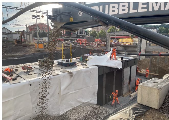
Hinterfüllung der Unterführung © Alex Kriebel
