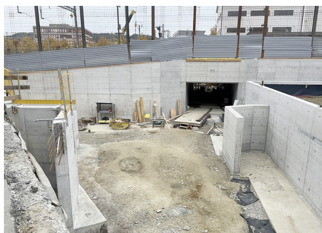
Fertige Stützwände, Stand Mitte Oktober 2025 © Alex Kriebel
