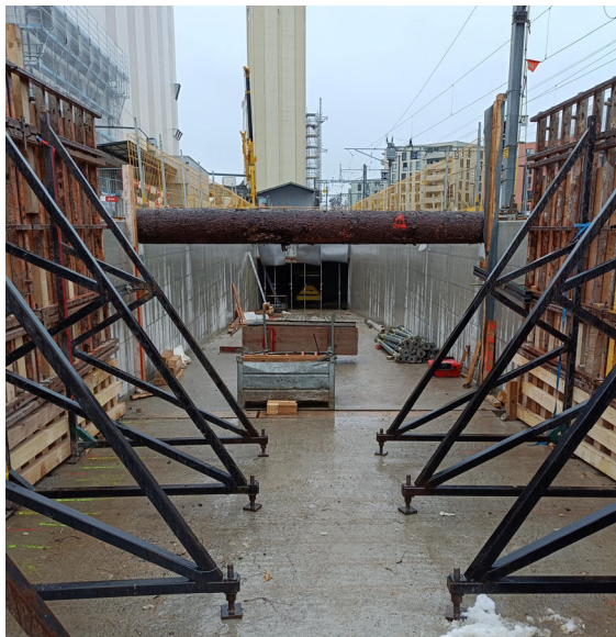
Zugangsrampe Seite Bahnhofplatz
